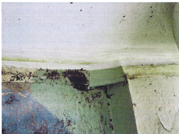
Foto nr 20. Lok 9. Dilatasjonsfuge m. fugebånd mot gavelvegg
