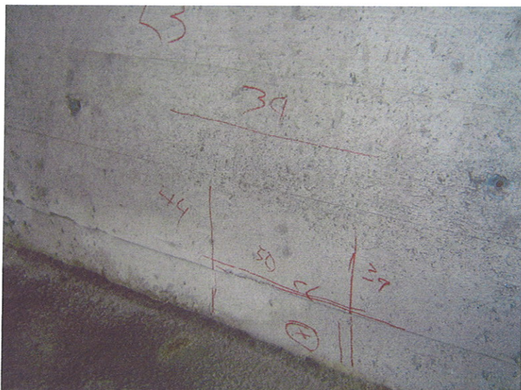
Foto nr. 7: Lokalitet 3, Armeringsføring i fundament, ned mot bakkenivå. Legg også merke til markering av plass for uttak av kloridprøve.
