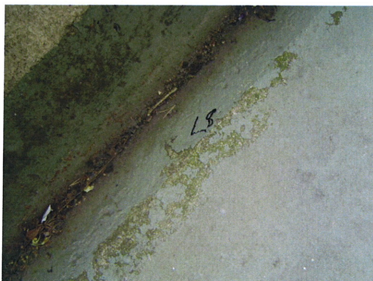
Foto nr 14. Mange gulv har gammel slitt maling.
