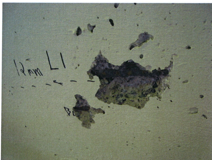
Foto nr. 2: Lok. 1 som foto 1. Opphugning viser tilnærmet ren armering selv om det er åpne porer inn til armeringen. Karbonatisering har delvis nådd armeringen.
